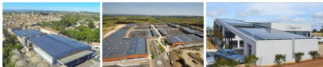
Les panneaux solaires sont installés en toiture et assurent parfois l'étanchéité du bâtiment.
